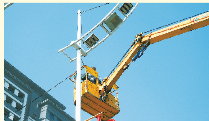
连日来,西华县城市管理局通过建立常态化排查检修机制,全面提升路灯管护水平,为群众营造安全、明亮的夜间出行环境。图为该局运维人员利用高空作业车对城区主干道上的路灯进行检修。
